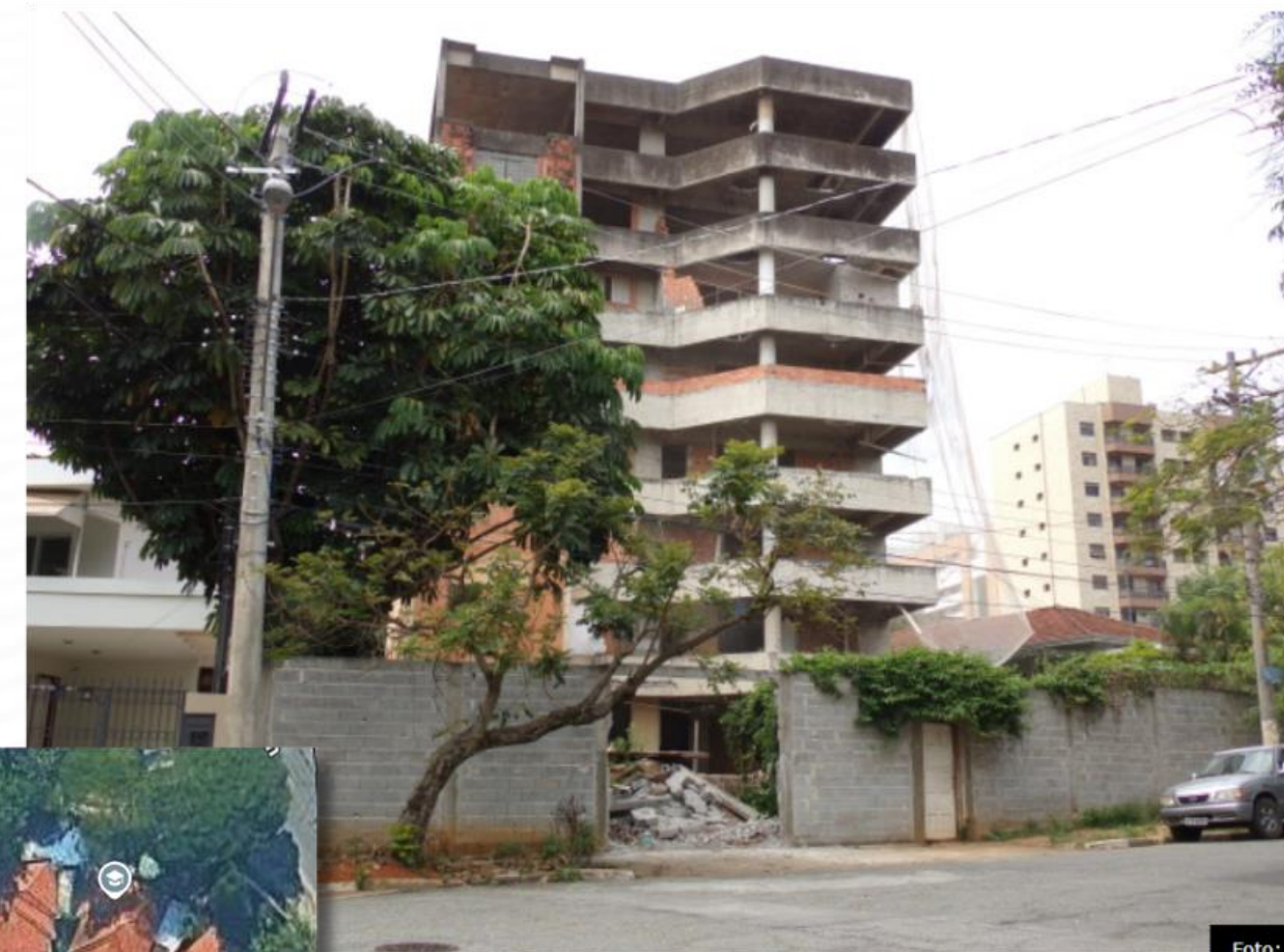
Início da demolição em 2015
