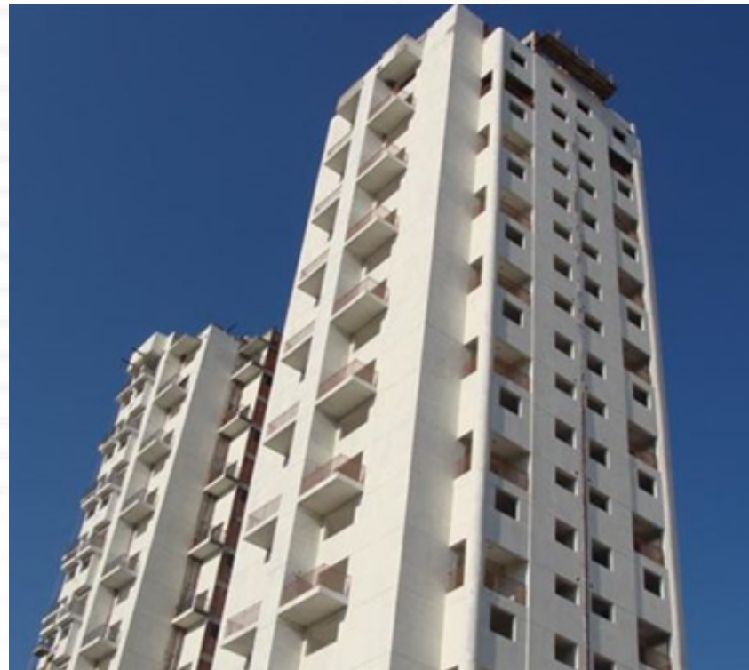
Duplex Vila Madalena – Cooperativa Apcefcoop – solução de desligamento da cooperativa. Nova incorporadora - Kallas
